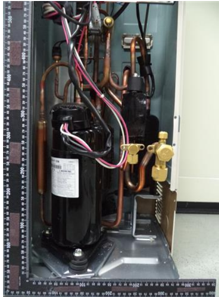
248. RAV-GP801AT-E, RAV-GP801ATJ-E, RAV-GP801AT-TR, Motor compressor
